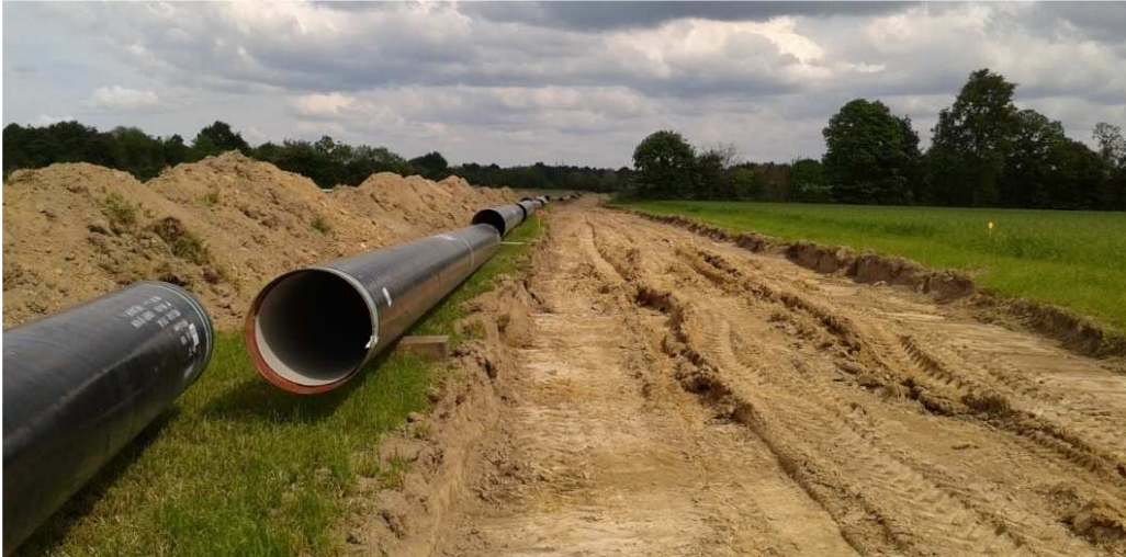
Figure 13 : Zone décapée et dépose des tubes - Source : Hydra-Setec
